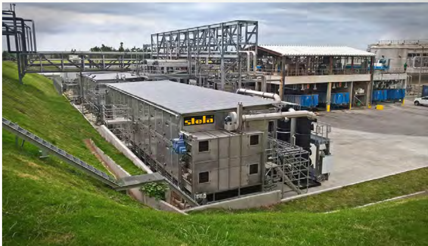
项目地：UPM S.A., 乌拉圭 | 型号：2x PBT 2/4000-21 | 安装年份：2017 干燥物料：生化污泥、磷污泥 | 蒸发量：8.0吨/小时
